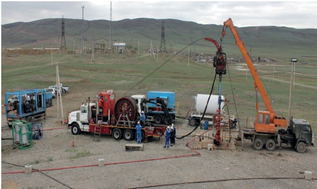
სურ. 2. ჭაბურღილში აზოტის გატუმბვა დრეკადი მილის დანადგარის გამოყენებით, საექსპლუატაციო პაკერის არსებობის პირობებში
