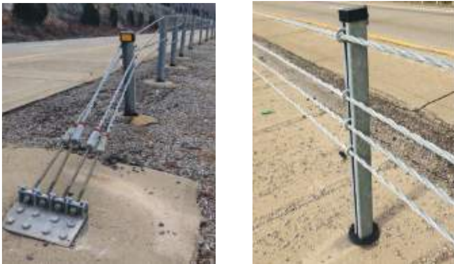
სურ. 3,4. საბაგირო ბარიერების კონსტრუქციული გადაწყვეტილებები ამერიკის შეერთებული შტატების მაგალითზე
