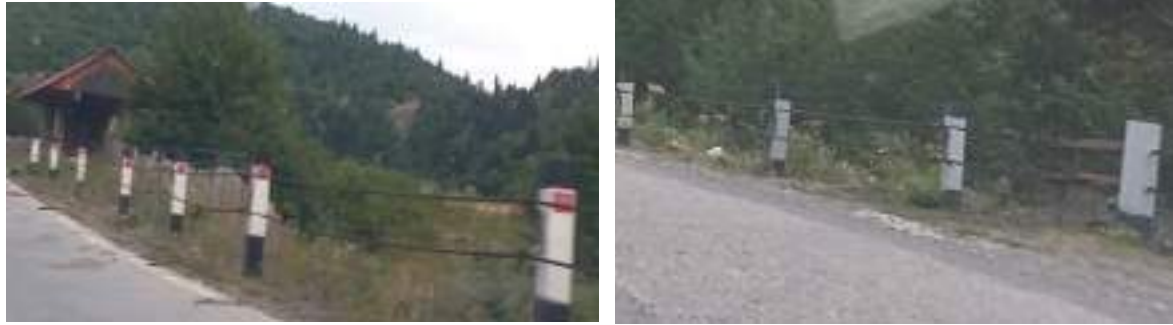
სურ. 1, 2. საბჭოთა სტანდარტით შესრულებული საბაგირო ბარიერები სამეგრელო - ზემოსვანეთის საგზაო მონაკვეთზე
